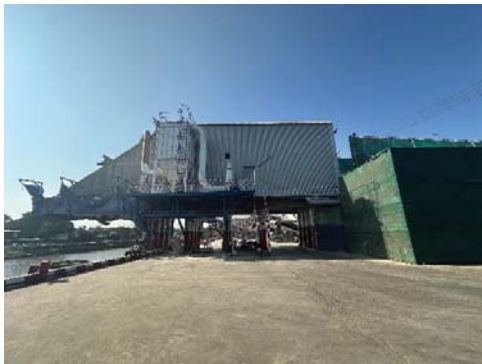
โกรกลงสินค้า A และเครื่องดักฝุ่นแบบถุงกรอง (Bag Filter)
